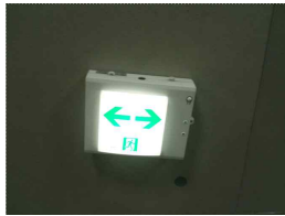
▲ 통로유도등이 올바르게 설치된 경우
