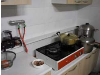
▲ 가스누설경보기가 미설치된 경우
