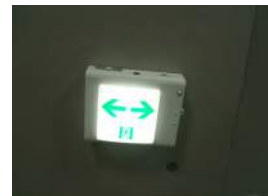
▲ 통로유도등이 올바르게 설치된 경우
