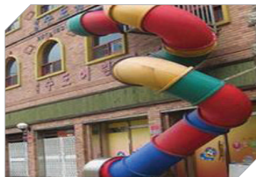
3층 어린이집에 설치된 미끄럼대
