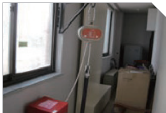
재난대비 양호등급 상태
