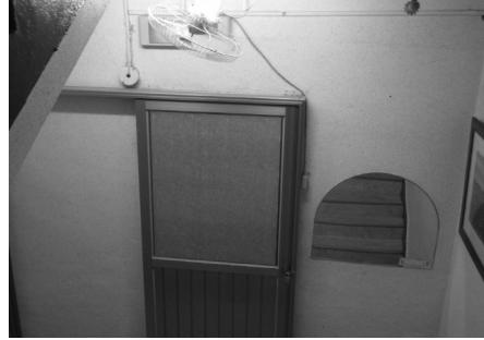
[장애물로 인한 유도등의 식별이 제한되는 경우]
