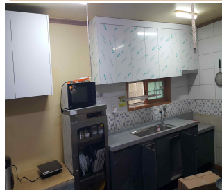
싱크대 철거 및 교체
