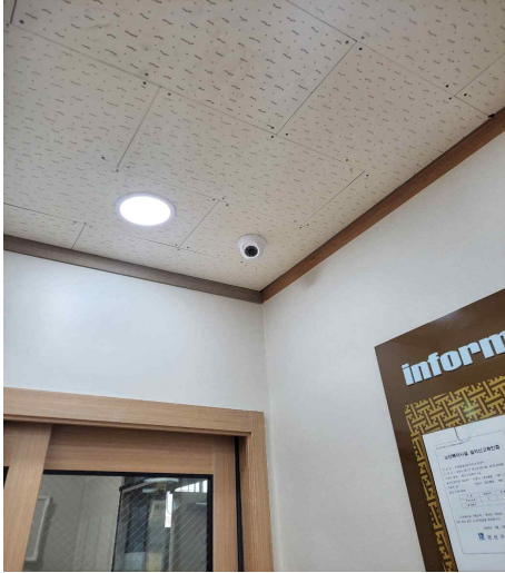
<<3층 2생활실 설치>>
