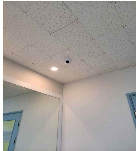
<<3층 1생활실 설치>>
