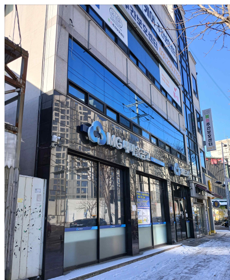
<<1층 건물현관외부 설치>>
