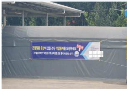
작업중지권 보장 현수막 설치
